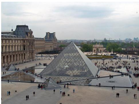
4. Techniquement, le polyèdre occupe une surface à sa base de  $1000 \text{ m}^2$ , s'élève à  $21,65$  mètres au-dessus du sol et se constitue de  $95$  tonnes d'acier,  $105$  tonnes de châssis en aluminium et  $673$  losanges de verre... bien que ce dernier point soit contesté par certains (lire le point 5).
