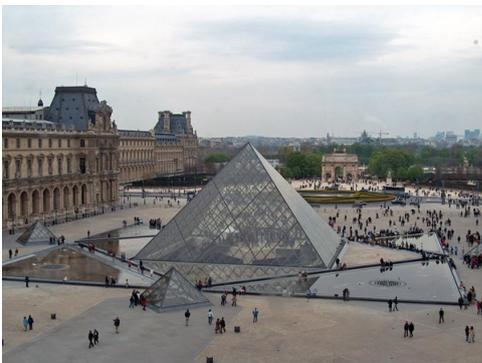
*4. Techniquement, le polyèdre occupe une surface à sa base de 1000 m<sup>2</sup>, s'élève à 21,65 mètres au-dessus du sol et se constitue de 95 tonnes d'acier, 105 tonnes de châssis en aluminium et 673 losanges de verre... bien que ce dernier point soit contesté par certains (lire le point 5).*
